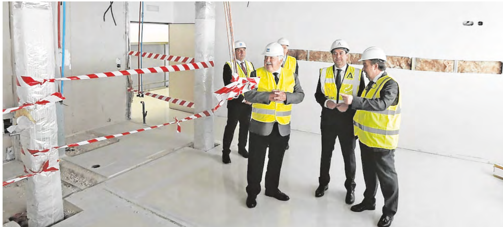
Jesús Aguirre, Juanma Moreno y Miguel Colmenero, director gerente del Virgen Macarena, inspeccionando ayer las obras del futuro centro sanitario // RAÚL DOBLADO
