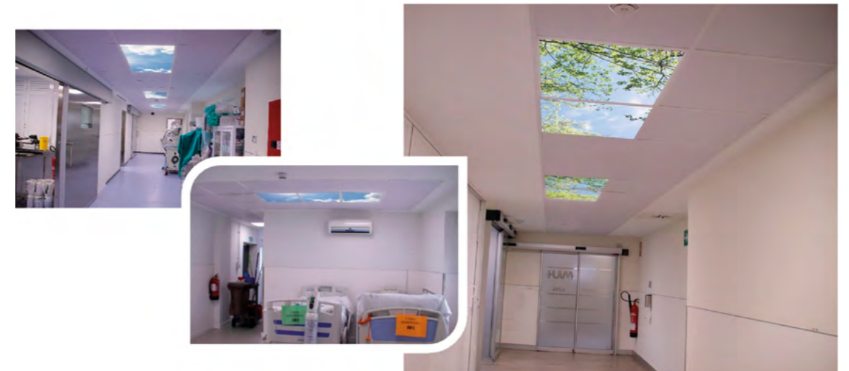
■ Luminarias del Área Quirúrgica. En fase de ejecución.
